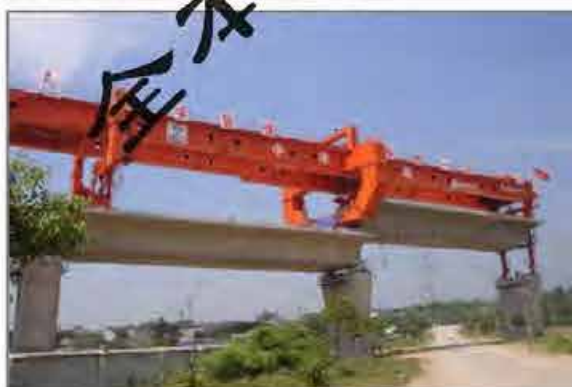
整孔预制吊装施工
